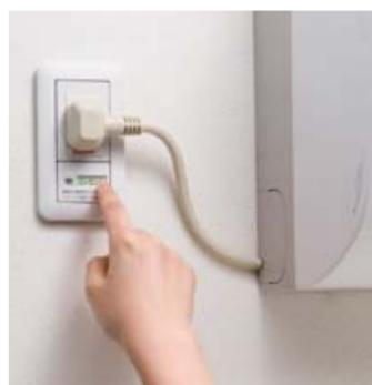
写真のコンセントに交換すると、「入」「切」のスイッチが付いています。「切」にすると待機電力が完全に0になり、コードを抜いた時と全く同じ効果になります。コードがだらんとせずに見た目もキレイですし、手を伸ばして軽く触れれば「入」「切」出来ます！これなら椅子に乗らなくてもお父さんであればデキルはず！節電とお母さんが怪我しない為にどうですか♪
